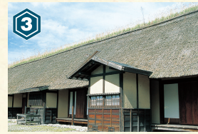
旧安中藩武家長屋 月曜日(祝日除く) 9:00~16:00 安中藩士の一般的な居宅である4軒長屋。
